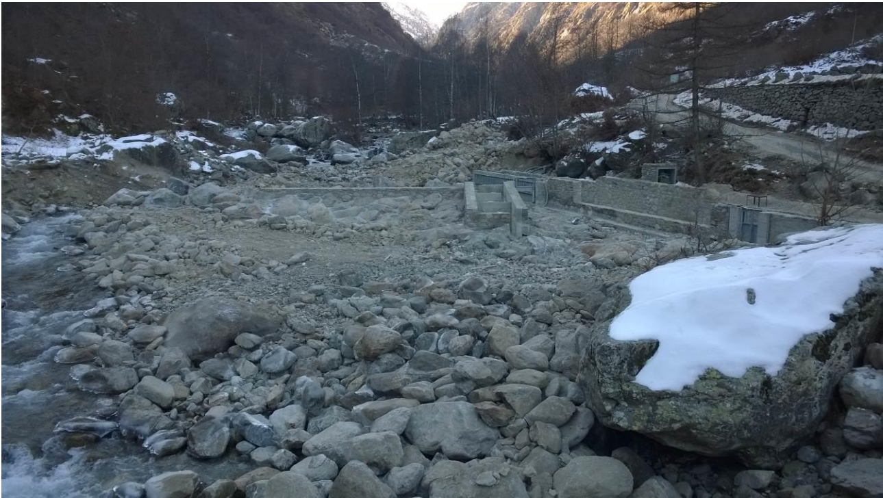
Foto scattata il 02.01.2015: fasi conclusive delle attività edili in alveo.
