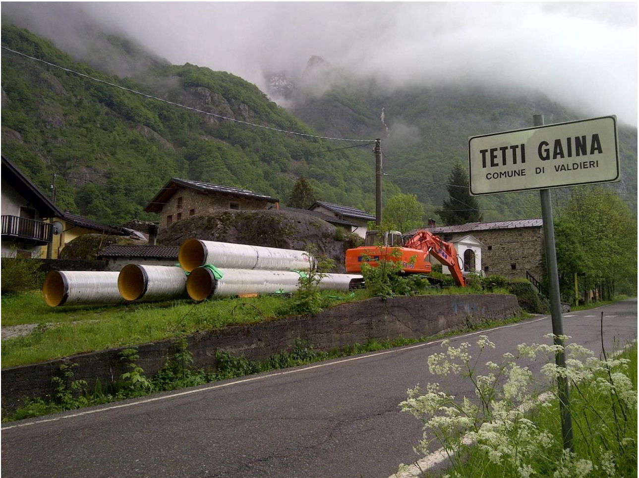
Foto scattata il 22.05.2014: prime attività di allestimento cantiere.
