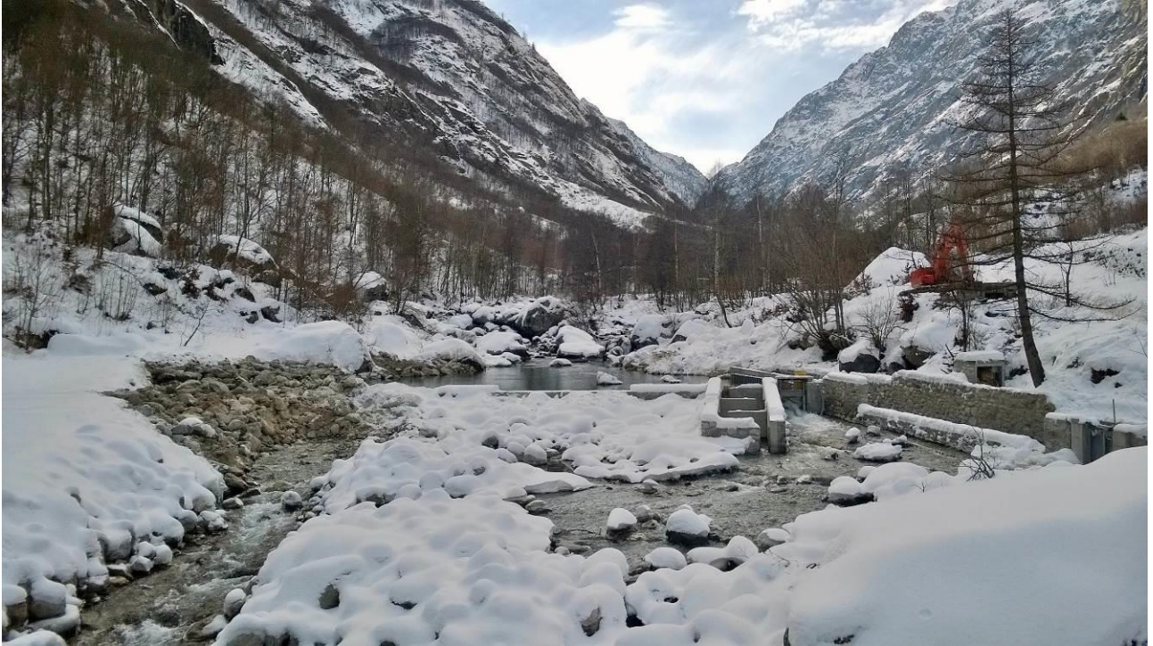
Foto scattata il 31.01.2015: il lavoro in alveo è quasi completato. In primo piano il passaggio pesci realizzato.
