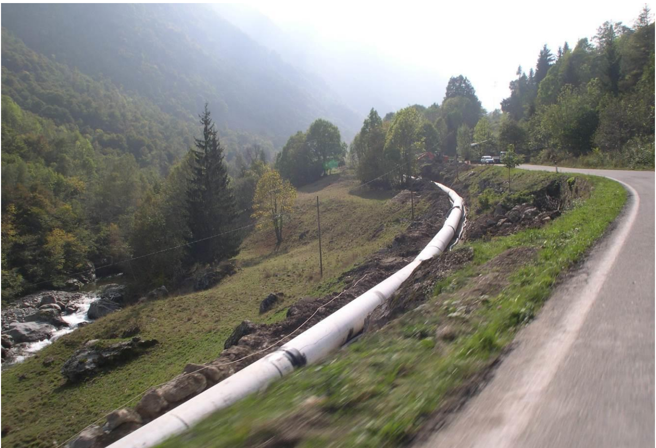
Foto scattata il 03.10.2014: posizionamento delle tubature (1 metro di diametro) sopra la frazione di Tetti Gaina.
