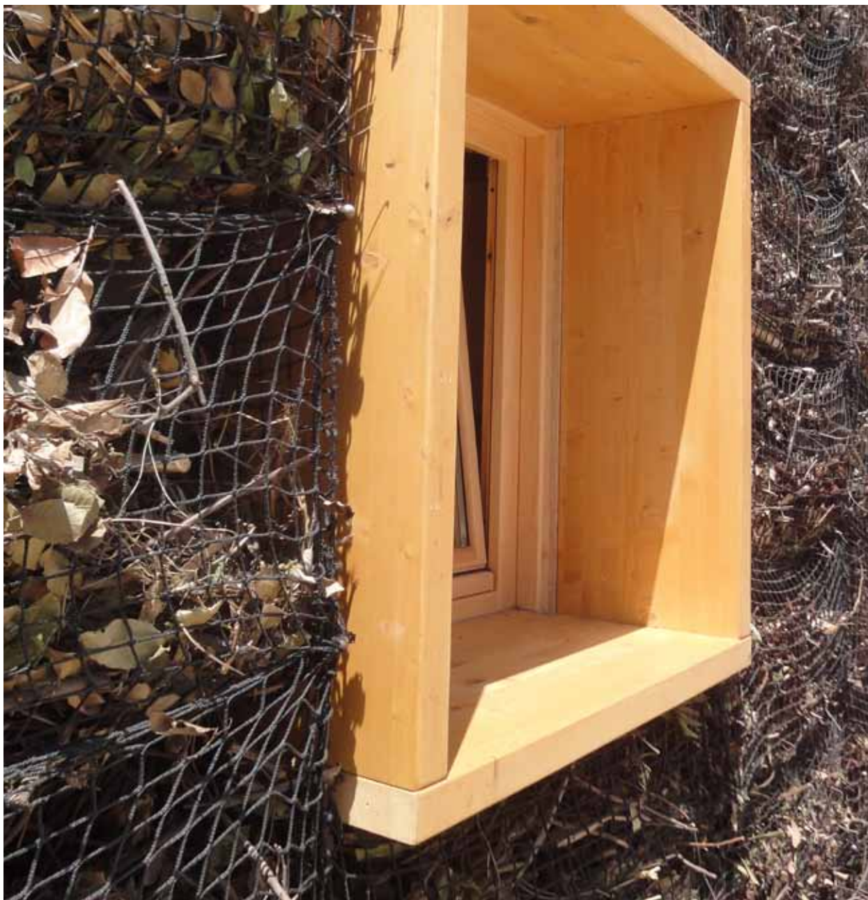
Dettaglio delle ceste prodotte dal retificio LA RETE, prodotte con Filo Econyl® di AQUAFIL: da notare le ceste riempite in sfogliato naturale, scelta specifica adottata per il prototipo esposto al MAXXI di Roma
